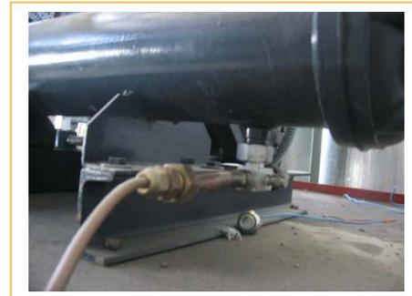
Fig. 38: Válvula de salida para refrigerante líquido.
