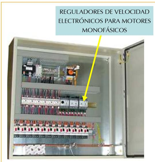
Fig. 55: Sistema de control en condensadores de aire Friga-Bohn.
