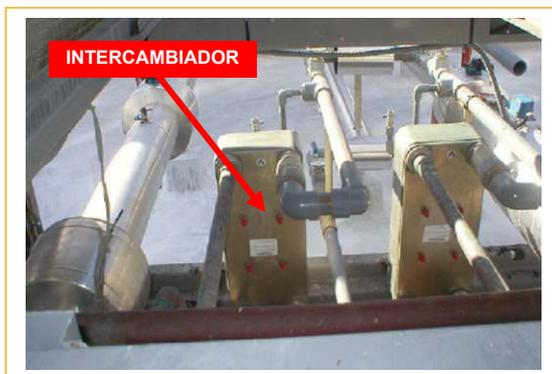
Fig. 63: Intercambiadores de calor a la salida del compresor.
