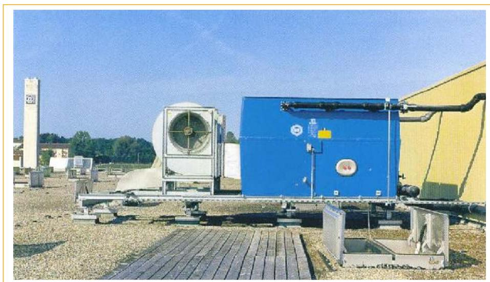
Fig. 49: Instalación de una torre de refrigeración.
