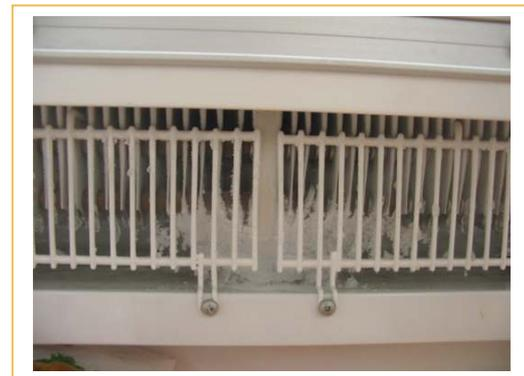
Fig. 16: Isla de productos congelados con aparición de escarcha.
