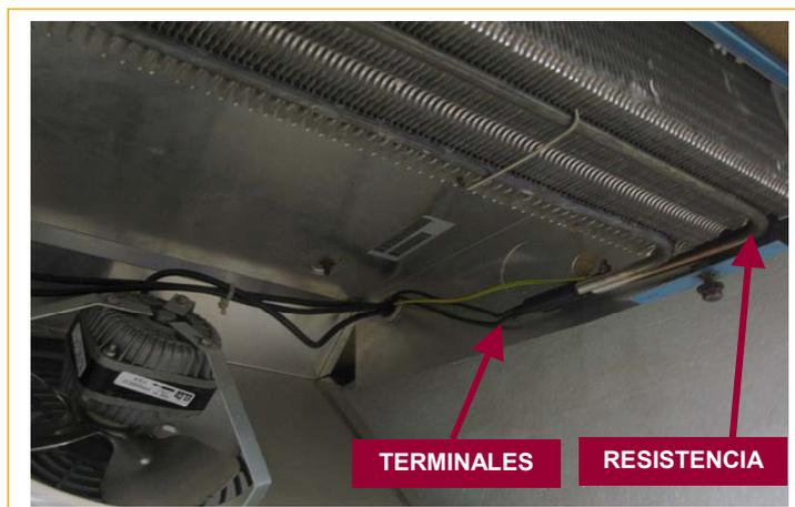
Fig. 20: Evaporador con resistencia eléctrica para desescarche.
