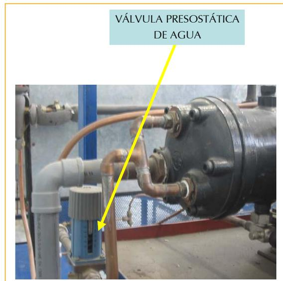
Fig. 56: Válvula presostática en condensador de agua.
