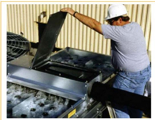
Fig. 47: Sistema de entrada de agua a la torre.
