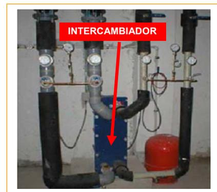
Fig. 64: Intercambiador de calor entre el agua de uso y la calentada a la salida del compresor.
