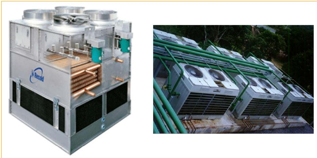
Fig. 52: Instalaciones típicas de condensadores evaporativos.
